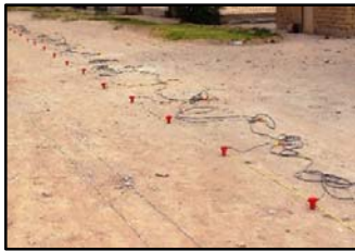
Fig. 11: Tendido de cable de Refracción
