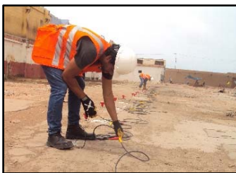
Fig. 11: Tendido de una línea de MASW
