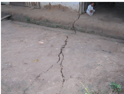
Figura 13: Licuación de suelos y Agrietamientos, ciudad de Moyabamba
